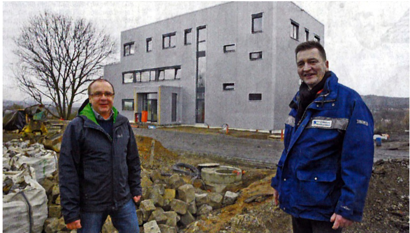
Arbeitsbesprechung vor dem neuen Bürogebäude: Johann Unglaub (r.), Geschäftsführer der Edelstahlwerke Schmees und Heizungsfachmann Lutz Gleisenberg.
